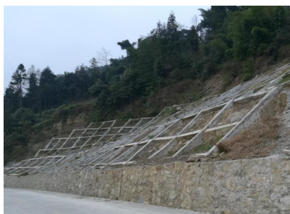
锚杆框架梁防护边坡
