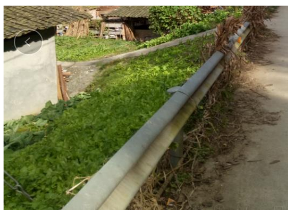
植被防护边坡
