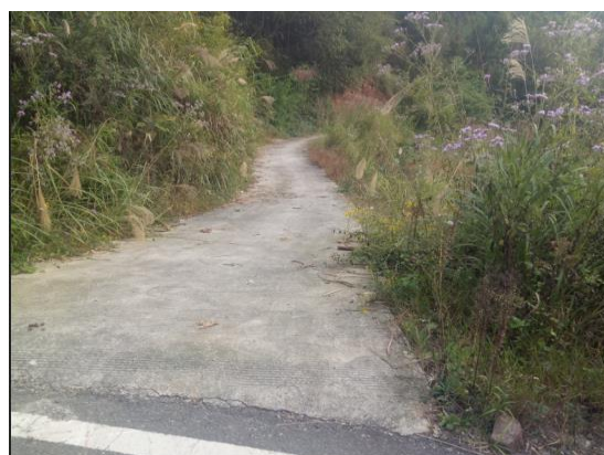
部分施工便道现状图
